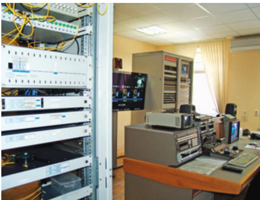
АЦ-КРА ГТРК «Южный Урал». На переднем плане оптические приемники/передатчики «Профитт» для приема и передачи программ, в центре «Форвард-ТП» (видеосервер межпрограммных заставок, субтитрование бегущей строкой, наложение сводок погоды). Параллельно тракту SDI создан резервный композитный тракт на базе аппаратуры «Профитт» – коммутационной матрицы, устройств вложения и извлечения звука, преобразователей сигналов SDI в композитные и обратно
